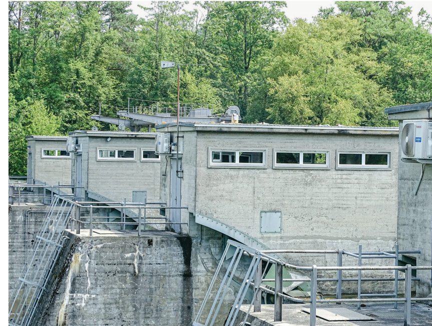
Die Flusseeeschwalben werden zum Brüten auf den Flachdächern der Stauwehripfeiler animiert
